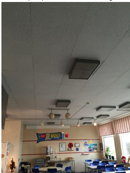
Ljudabsorbenter i matsal fyller inte sin funktion, för hård yta.
