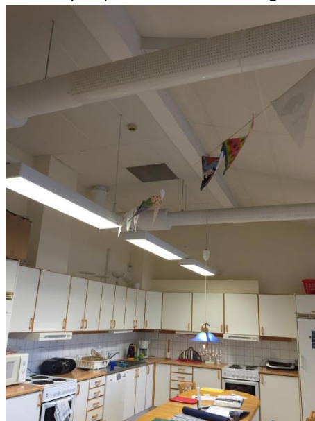
Exempel på bättre dragning ventilation i Fritids del. Gjort vid en tidigare entreprenad.
