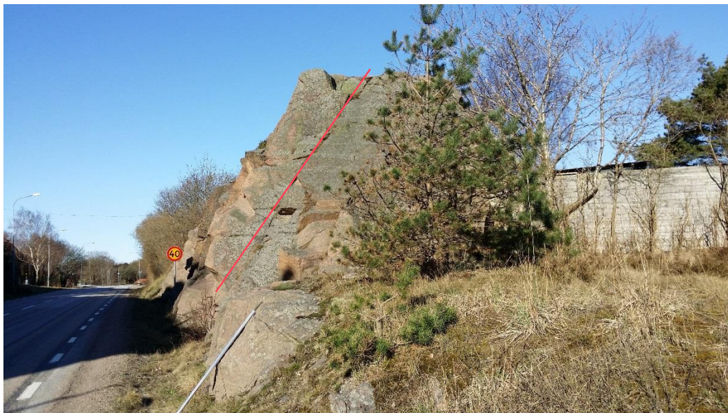
Figur 5 Den norra sidan av den norra bergskärningen, där brantstående spricka är markerad i rött
