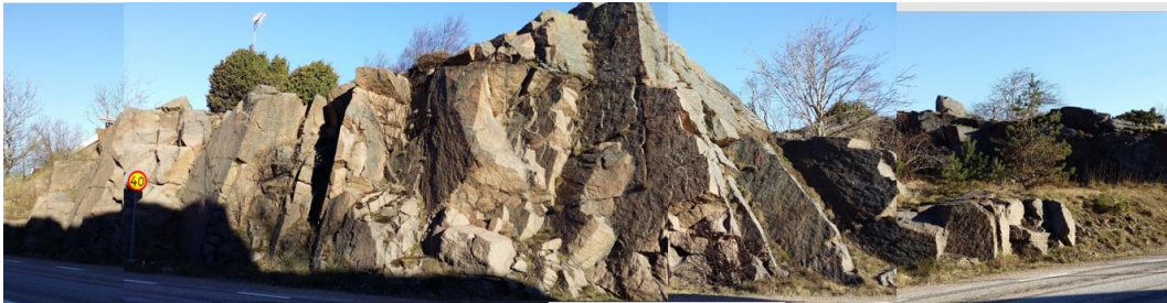
Figur 4 Den norra sidan av den norra bergskärningen längs Dinglevägen
