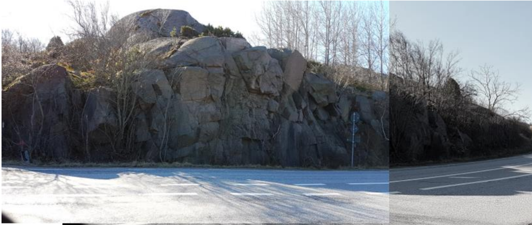
Figur 2 Den södra bergskärningen längs Dinglevägen (väg 174)
