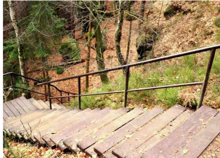
Exemplar på trätrappa med stålräcke
