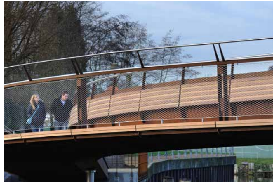
Exempel på stålräcke och träyta
