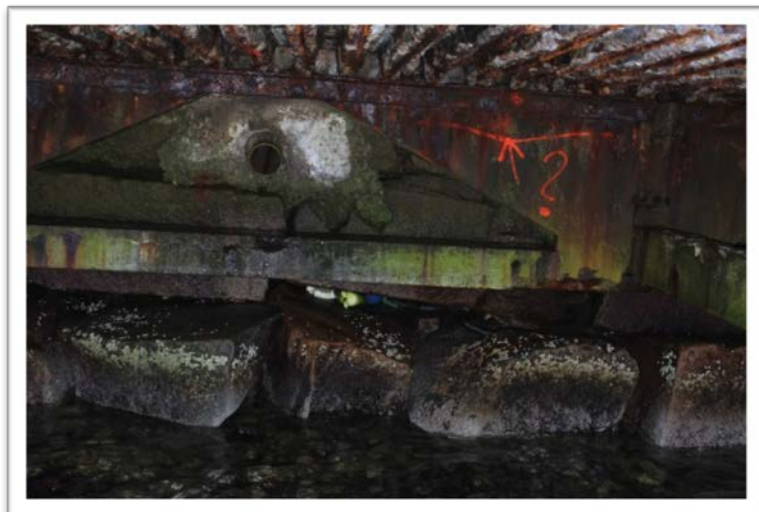
Figur 3b: Befintlig balk på fyllning.
