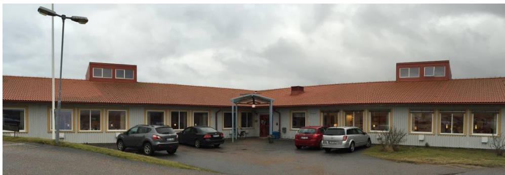
Fasad med ljusinsläpp på tak.
