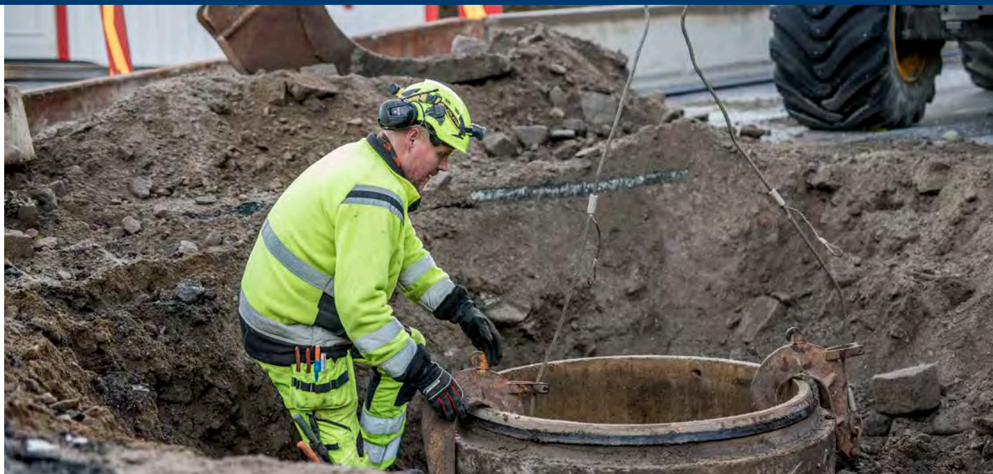
Lagning av huvudventil som förser Malmön med vatten /Sotenäs Vatten AB Fotograf: Viktoria Olsson
