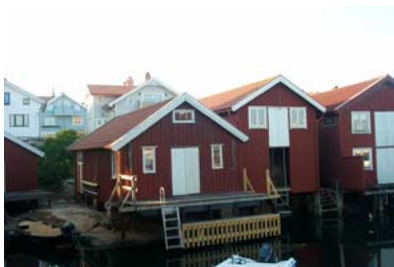
Fisket krävde täta, kustnära samhällen där rummen mellan byggnaderna utgjorde skydd mot det stränga klimatet.
