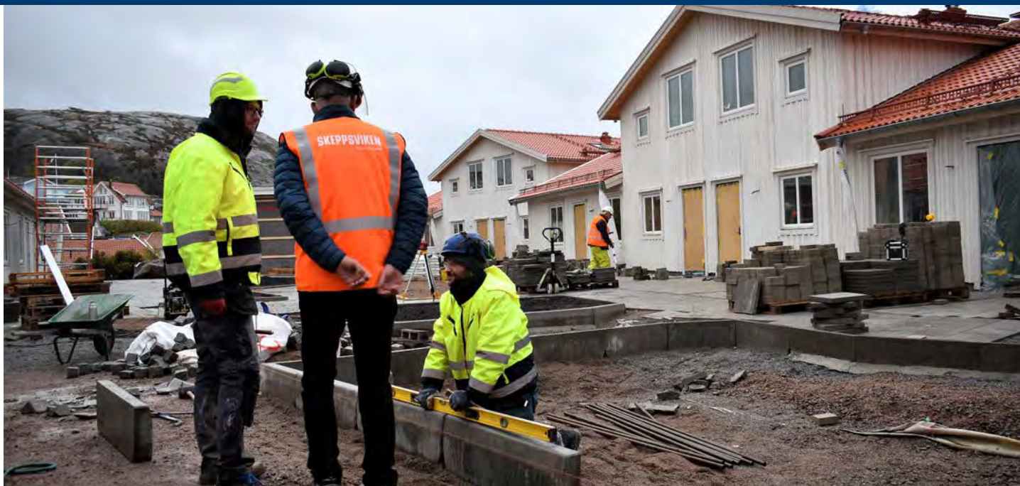
Bostadsbolaget har byggt 36 nya lägenheter för äldre på Bankeberg i Hunnebostrand
