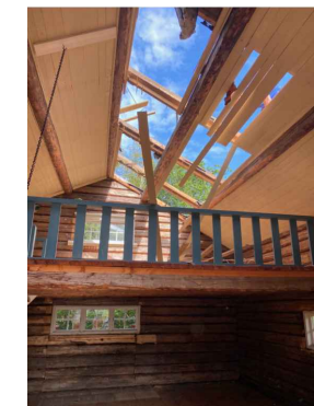
Befintligt loft under demontering.
